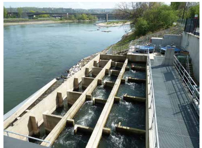
Fischeufstiegsanlage an der Staustufe Koblenz in der Mosel Quelle: Stephan Naumann
